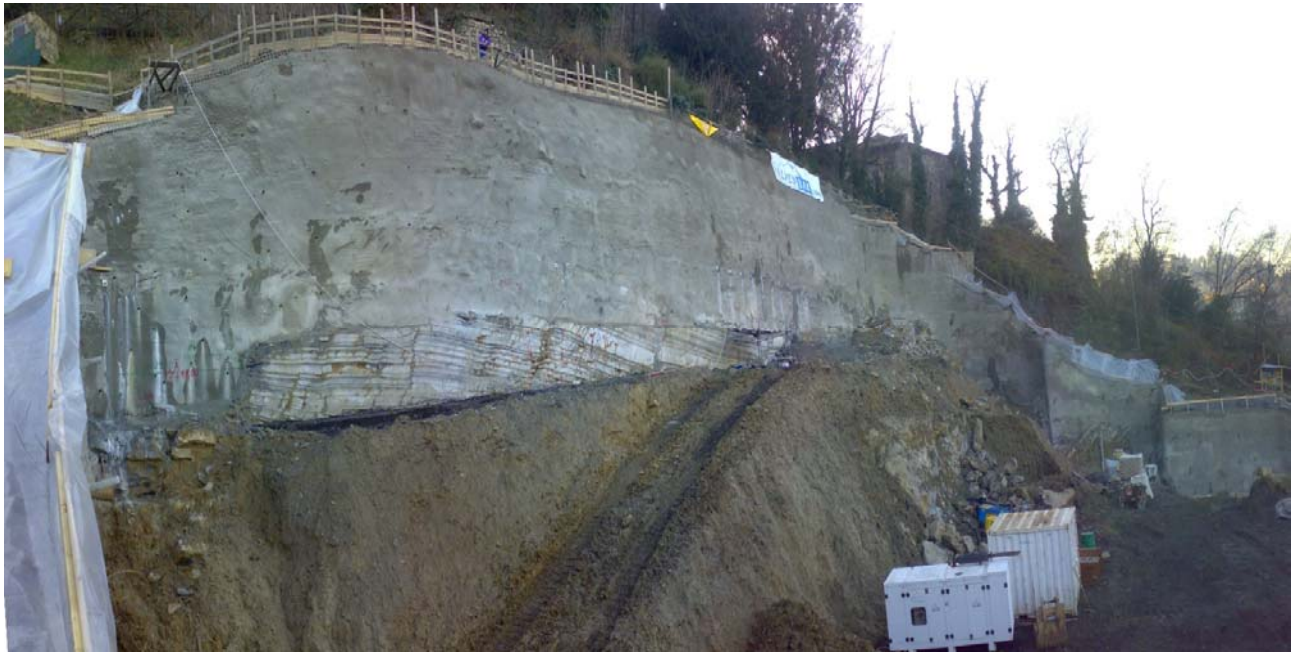
Foto 1-2: fronte di scavo principale
